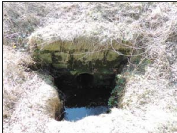
Obr. 14 – Okraj lesa, poslední objekt na trase zatrubnění
