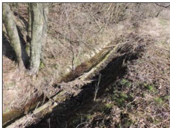
Obr. 12 – Koryto z betonových prefabrikátů
