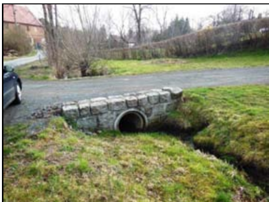
Obr. 11 – zatrubnění v úseku
