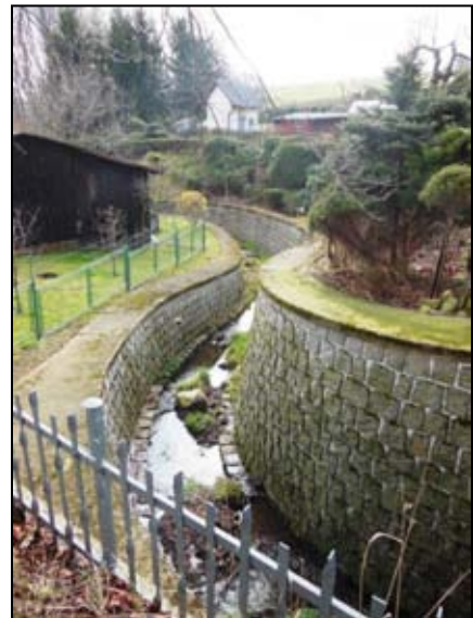
Obr. 10. – opevnění toku kamennými zdmi
