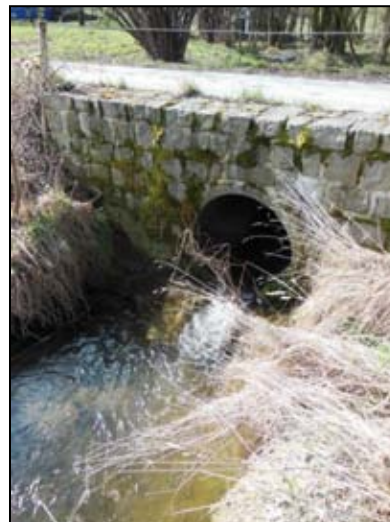
Obr. 2 – Zatrubnění pod místní komunikací
