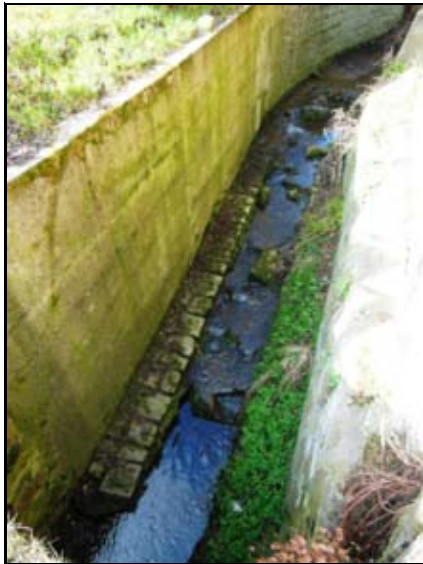
Obr. 9 – betonové opevnění toku
