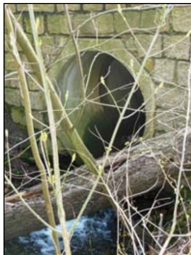
Obr. 6- zatrubnění pod komunikací z Andělky do Vsi
