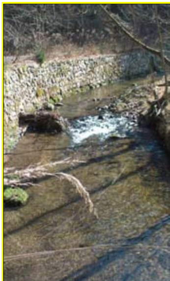
Obr. 5 – Opevnění pravého břehu, nad kterým probíhá lesní cesta
