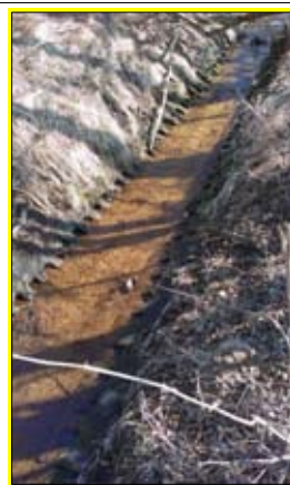
Obr. 18 - Opevnění koryta
