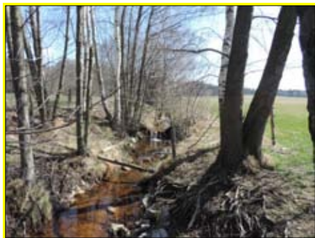
Obr. 17 – Upravené koryto s betonovými stupni
