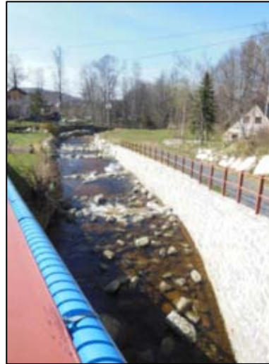
Obr. 2 - Pohled po proudu z mostu – vpravo opěrná zeď
