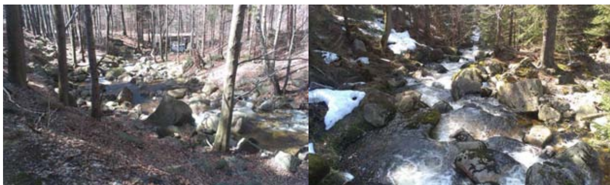
Obr. 3 – Pohled po proudu ve spodní části úseku k mostu Obr. 4 - Pohled po proudu ve střední až horní části úseku
