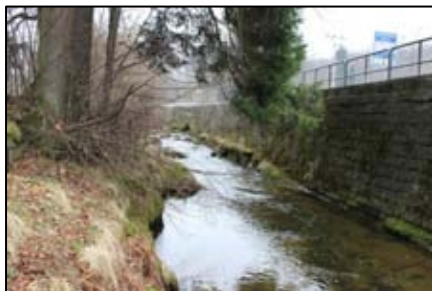
Obr. 1 – Pohled proti proudu na část opevněnou kamennou zdí
