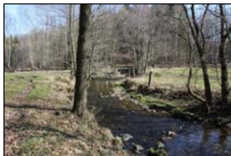
Obr. 6 – Pohled proti proudu směrem na most na konci úseku
