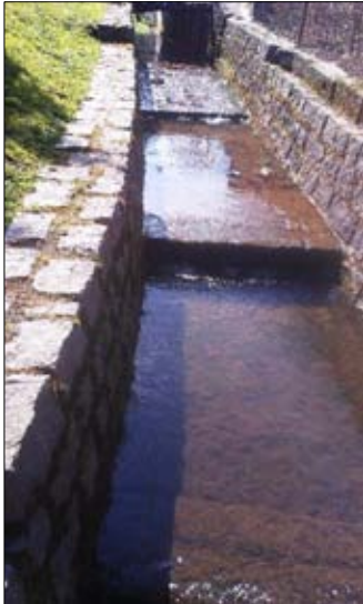
Obr. 5 – Opevnění toku v obci
