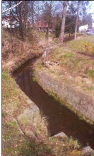
Obr. 3 – Pohled proti proudu ve spodní části úseku
