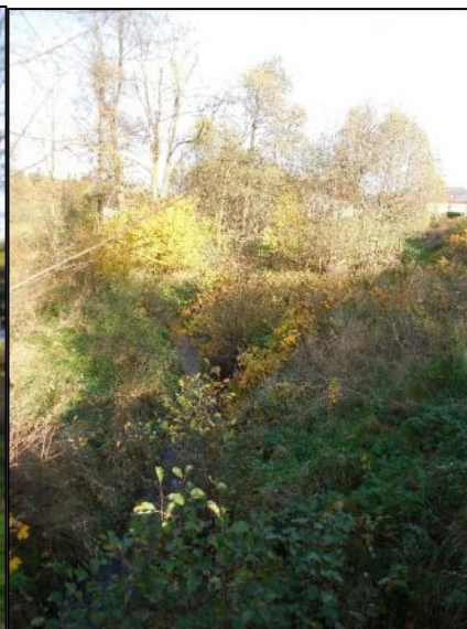
Obr. 1.51 – Přírodní charakter koryta nad obcí (ř. km 0,390)
