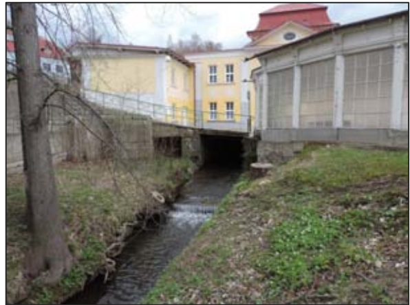
Obr. 4 - Pohled proti proudu, tok opouští podzemní koryto
