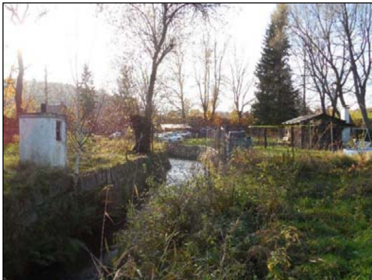
Obr. 1.50 – Dolní opevněná část úseku mezi zahradami (ř. km 0,130).
