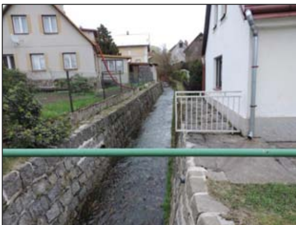
Obr. 5 – Zkapacitněné koryto
