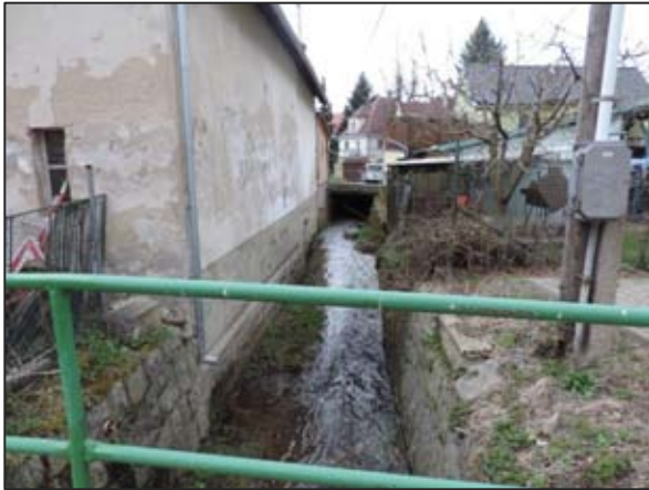
Obr. 3 – Pohled po proudu, vtok do podzemního koryta
