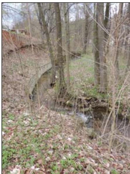
Obr. 1 – Pohled po proudu, opevnění konkávního břehu
