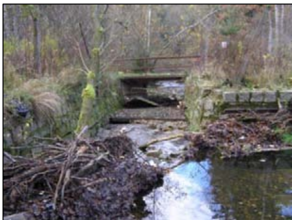
Obr. 1.12 – Pohled po proudu na začátku úseku na hranici kat. území (ř.km. 7,189).
