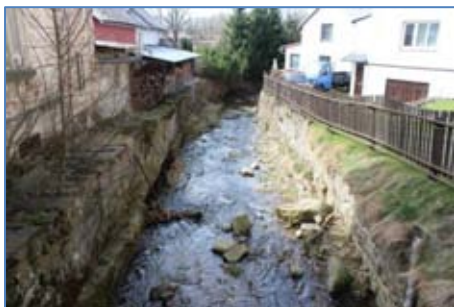
Obr. 5 – Pohled po proudu na koryto toku vedoucí z objektu Textilany
