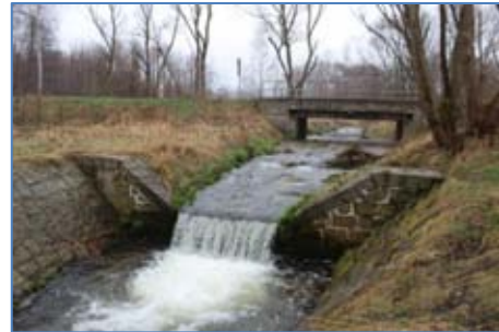
Obr. 4 - Pohled proti proudu na první jez na 8,4ř.km
