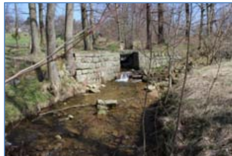
Obr. 8 – Pohled proti proudu přítok z koupaliště
