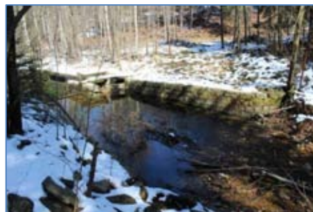
Obr. 10 – Pohled po proudu na jez
