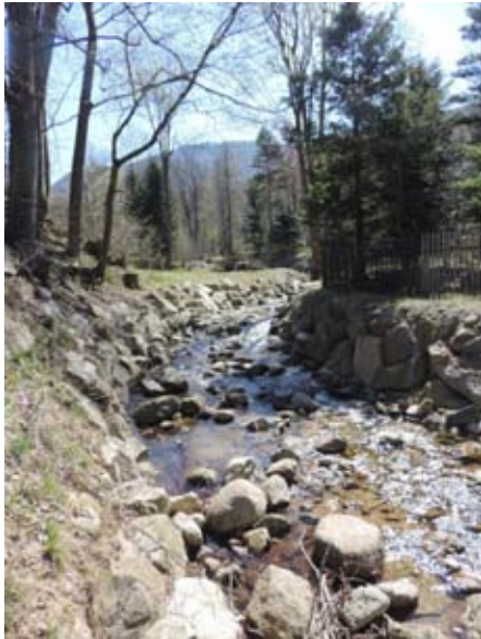
Obr. 3 – Pohled proti proudu, opevnění kamennou rovnaninou Obr. 4 - Pohled po proudu, oboustranné opevnění kamennou zdí
