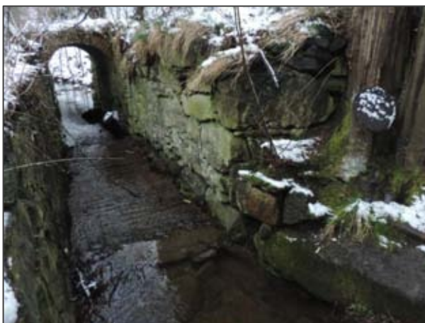
Obr. 5 – Pohled po proudu, opevněné koryto před mostem
