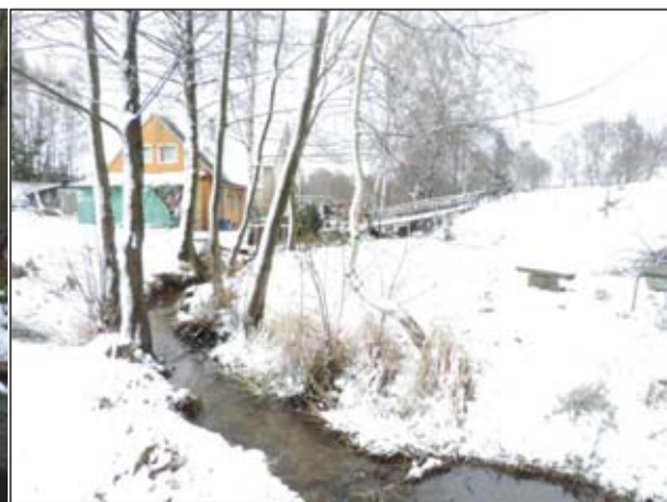
Obr. 6 - Pohled po proudu, tok mezi zástavbou
