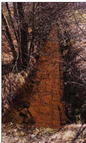
Obr. 7 – Dláždění koryta na začátku druhé třetiny úseku
