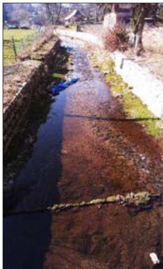
Obr. 5 – Opevnění toku v obci
