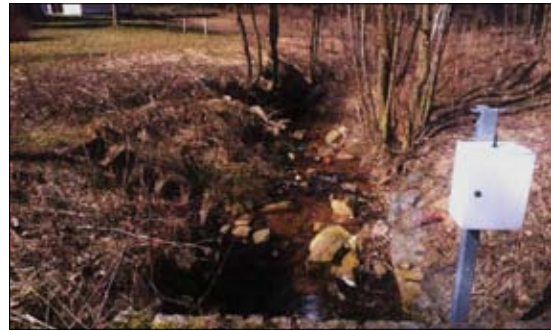
Obr. 12 – Pohled na zpevněnou část nad rybníkem
