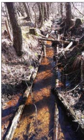
Obr. 1 – Pohled po proudu – dřevěné opevnění
