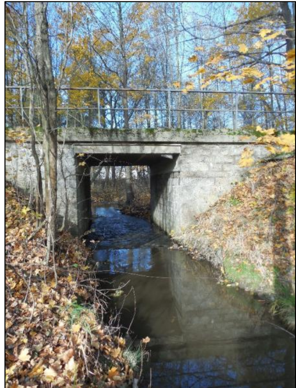
Obr. 1.41 – Konec úseku u silničního propustku na ř. km 0,800.
