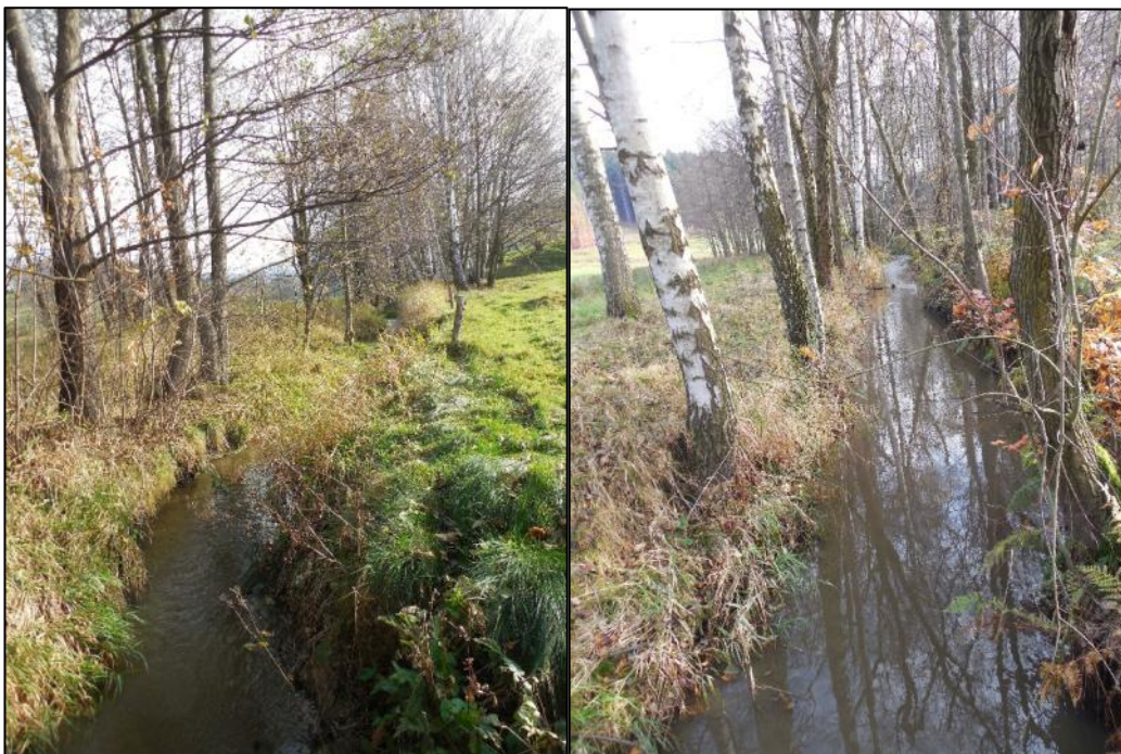
Obr. 1.29, 1.30 – Dolní část úseku (ř. km 0,800 - 1,900) - cca 1 m široké nezpevněné koryto s břehovými porosty mezi pastvinami.
