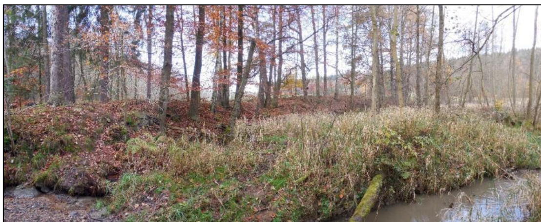
Obr. 1.31 – Hráz zaniklého rybníka na ř. km 2,115.
