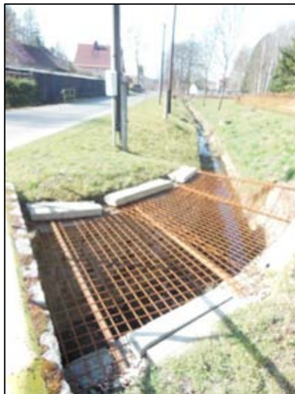
Obr. 6- Pohled po proudu – příprava na zakrytí koryta
