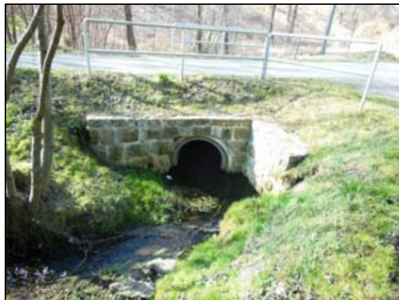
Obr. 8– Zatrubnění pod místní komunikací
