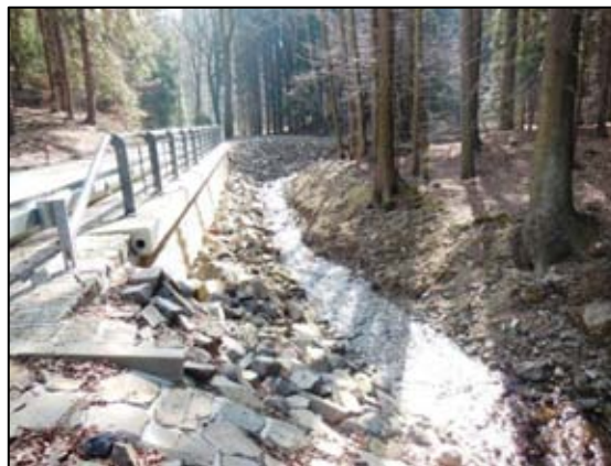
Obr. 2 - Pohled proti proudu – oprava silničního náspu na ř. km 1,000
