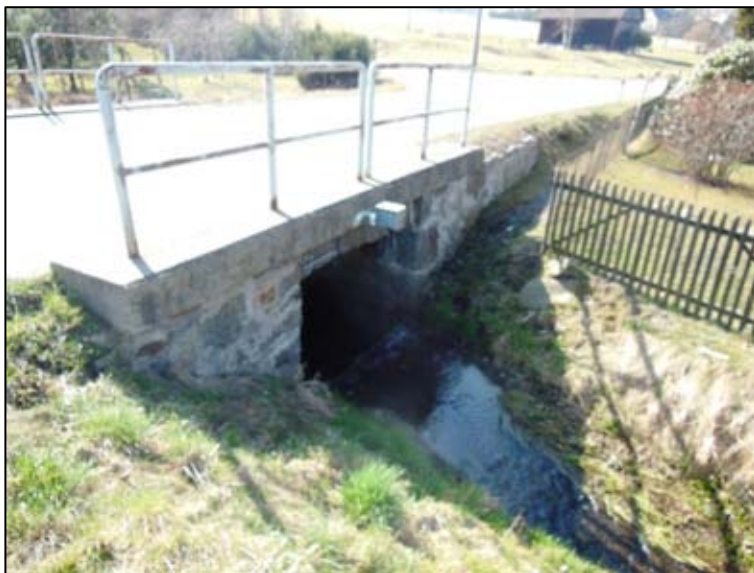
Obr. 4 - Pohled po proudu, jeden z mostků – tok je zde v mírném vzduťi
