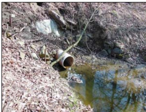
Obr. 10 – Pohled na zatrubnění pod hrází dolního rybníka
