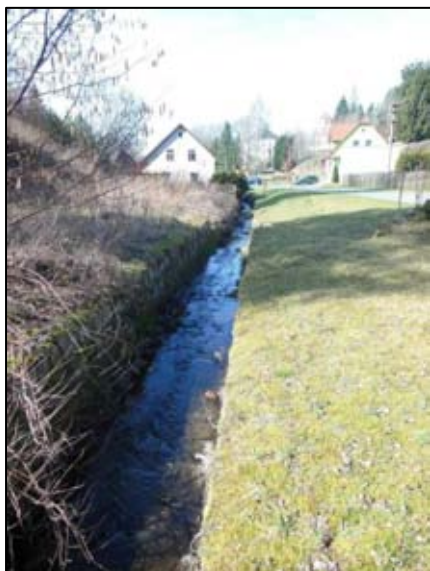
Obr. 5 – Pohled po proudu – opevněné koryto
