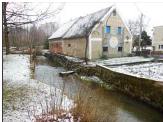
Obr. 10. Opevnění toku v blízkosti staveb, pohled proti proudu.
