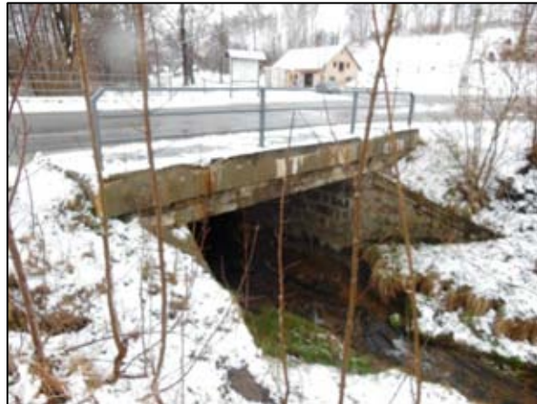
Obr. 20. Most v závěru úseku – křižovatka silnic do Horní Řasnice a do Jindřichovic
