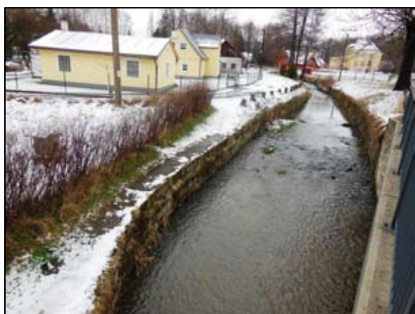
Obr. 11 – Pohled proti proudu – opevnění břehů a dna v blízkosti mostu
