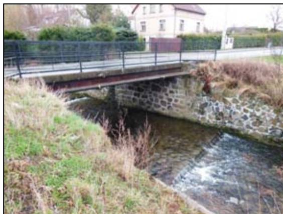
Obr. 4 - Pohled proti proudu, most v ulici Havlíčkova
