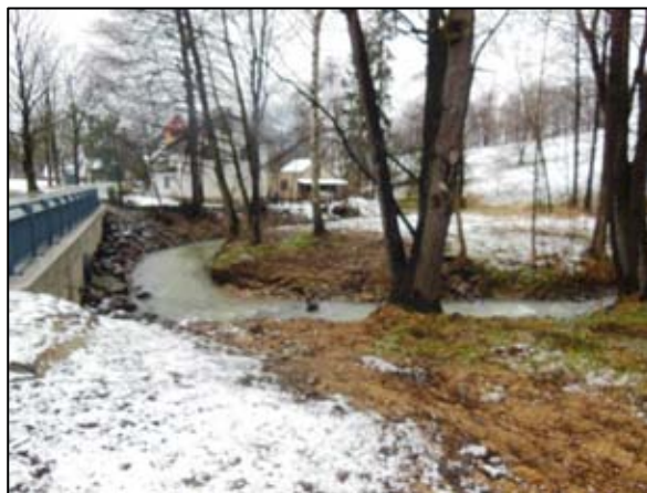
Obr. 12. Opevnění břehu v blízkosti silnice, pohled po proudu.
