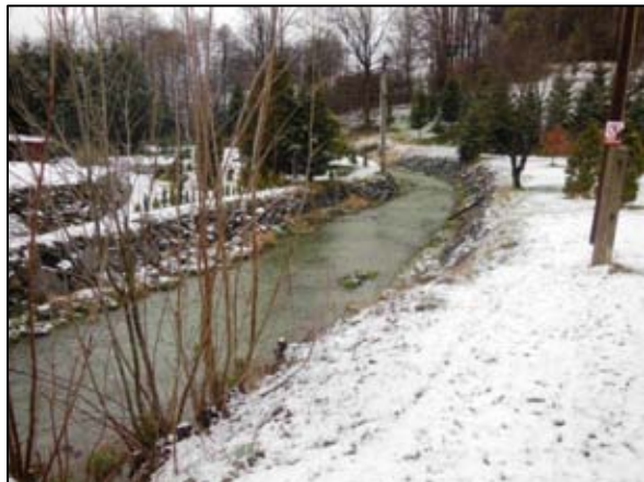
Obr. 13 – Pohled proti proudu – opevnění břehů z kamene na počátku úseku
