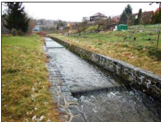
Obr. 3 – Pohled proti proudu – opevnění toku
