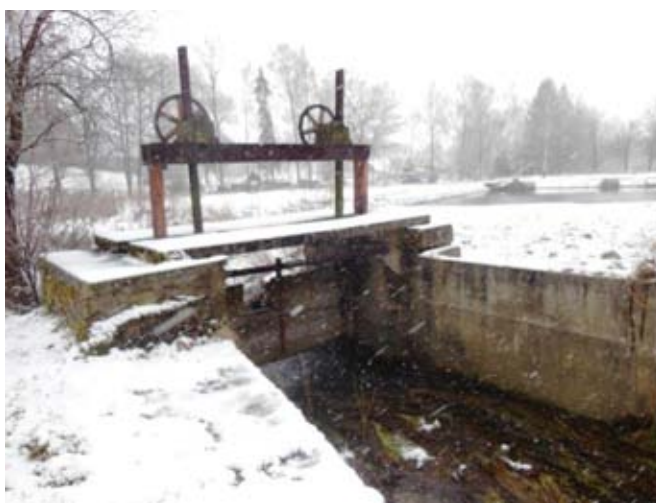
Obr. 23 . Průběh toku v úseku, pohled proti proudu Obr. 24. Stavidlo na toku a požární nádrž
