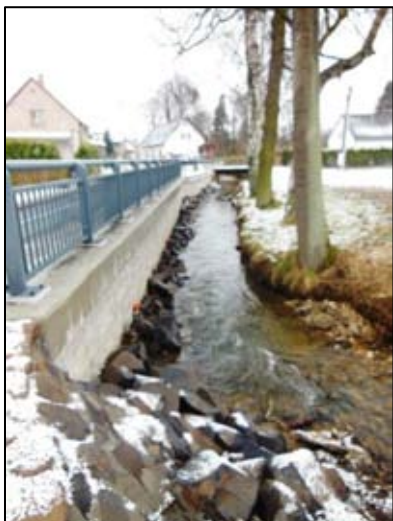
Obr. 15 . Pohled po proudu betonové opevnění levého břehu kvůli silnici
