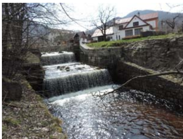
Obr. 5 – Pohled proti proudu, tok mezi zástavbou Obr. 6 – Pohled proti proudu, stabilizace podélného sklonu dnovými stupni
