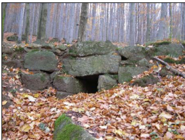
Obr. 1.47 – Kamenný propustek na Viničné cestě.
