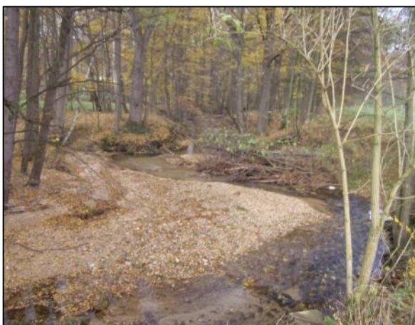
Obr. 1.45 – Pohled po proudu na začátku úseku na hranici kat. území (ř.km 1,330).
