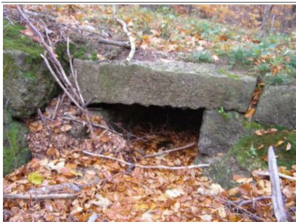
Obr. 1.46 – Kamenný propustek na drobném lesním přítoku Sloupského potoka.
