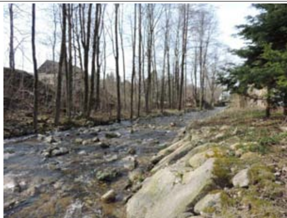
Obr. 3 – Pohled proti proudu, jednostranné opevnění kamennou zdí Obr. 4 - Pohled po proudu, jednostranné opevnění kamennou rovinaninou
