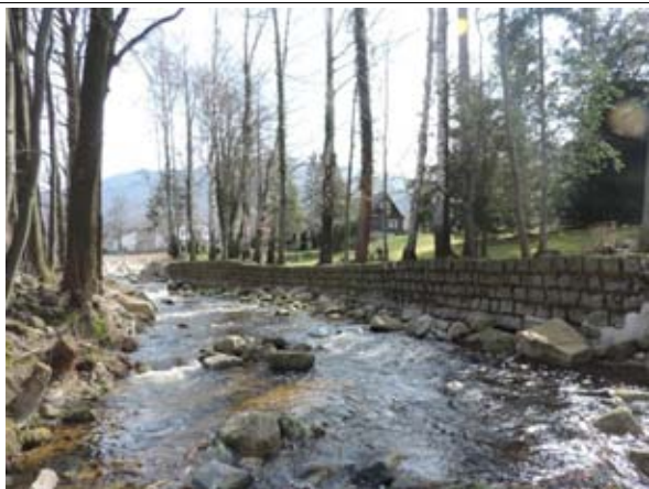
Obr. 3 – Pohled proti proudu, jednostranné opevnění kamennou zdí Obr. 4 - Pohled po proudu, jednostranné opevnění kamennou rovinaninou
