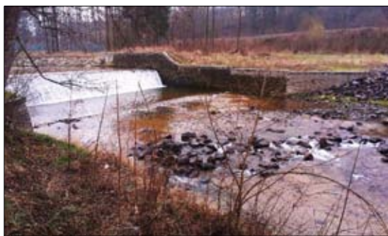
Obr. 9 - Pohled proti proudu na jez pod zámek
