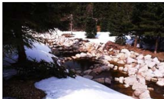
Obr. 16 – Balvanitý skluz s průtočnými tůňmi pod Smědavou
