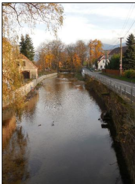
Obr. 1.3 – Smědá v ř. km 34,300.
