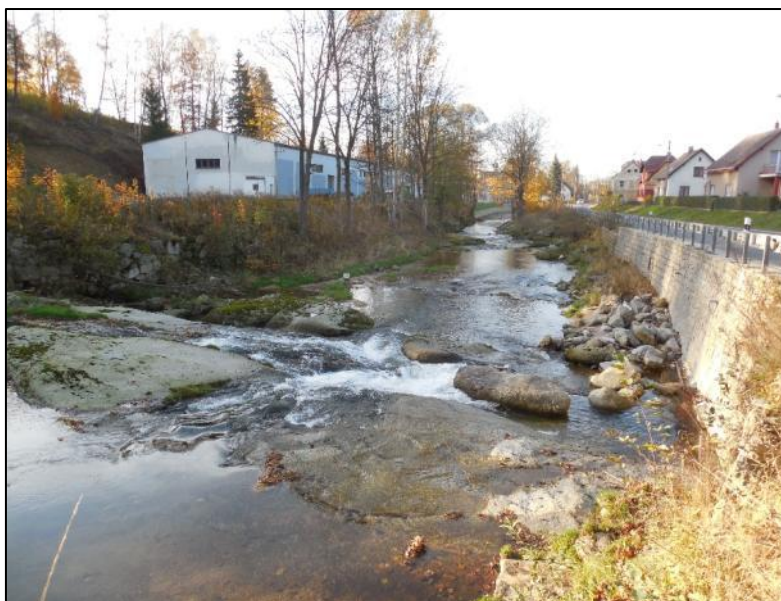
Obr. 1.4 - Smědá v ř. km 35,600.
