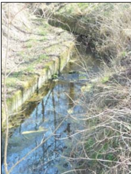
Obr. 5 – Pohled po proudu, vybetonované břehy
