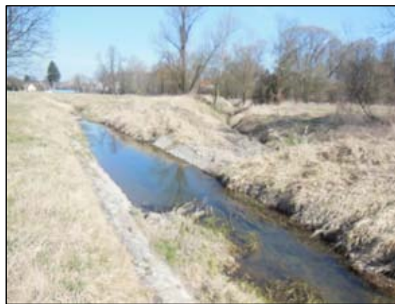
Obr. 2 - Pohled po proudu – vpravo odlehčovací kanál
