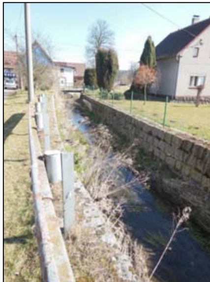
Obr. 4 - Pohled po proudu, vlevo místní komunikace
