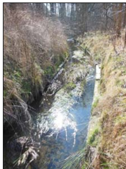
Obr. 6- Pohled proti proudu, břehy zpevněny betonovými prefabrikáty
