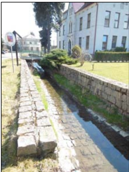
Obr. 3 – Pohled po proudu, koryto v horní části úseku
