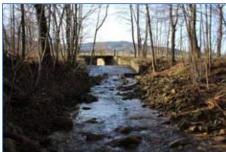
Obr. 5 – Pohled proti proudu na kamenný jez
