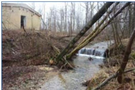
Obr. 3 – Pohled proti proudu v první části úseku
